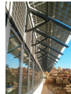
Verschattungsanlage DLR Neustadt
