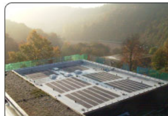
Flachdachsanierungen mit Fotovoltaikabdichtsystem Gymnasium Neuerburg
