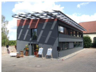
Passivhaus Trippstadt, erstes LBB-Energiegewinnhaus
