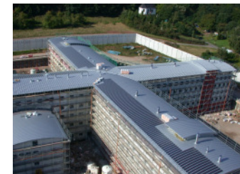
Tonnendach in der JVA Wittlich
