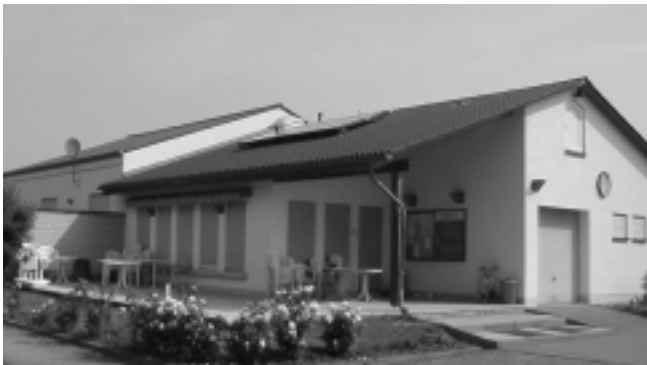
Abb.4: Solar-Kollektoranlage für Vereins-Duschen.
