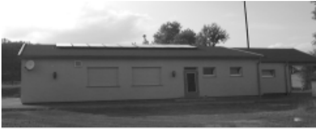
Abb. 2: Solaranlage mit 22 m 2 Kollektorfläche.
